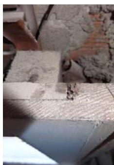
linea da seguire per il taglio del vecchio telaio
